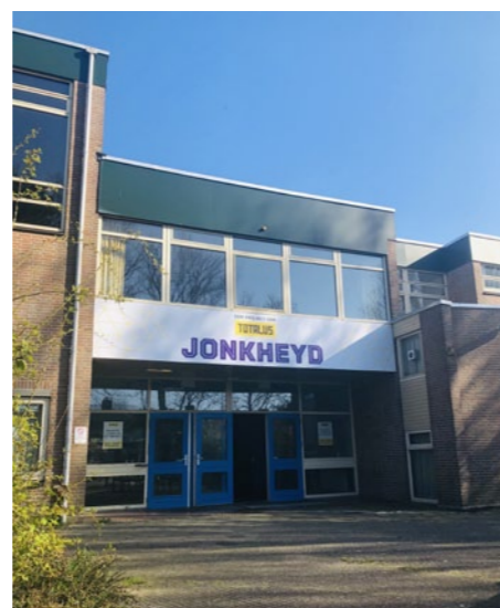
Jonkheyd: het creëren van 14 flexwoningen in een voormalig schoolpand
